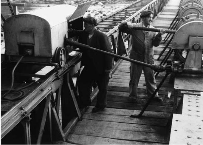
Stauwehr, Antrieb der Stauklappen mit dem fahrbaren Motor
