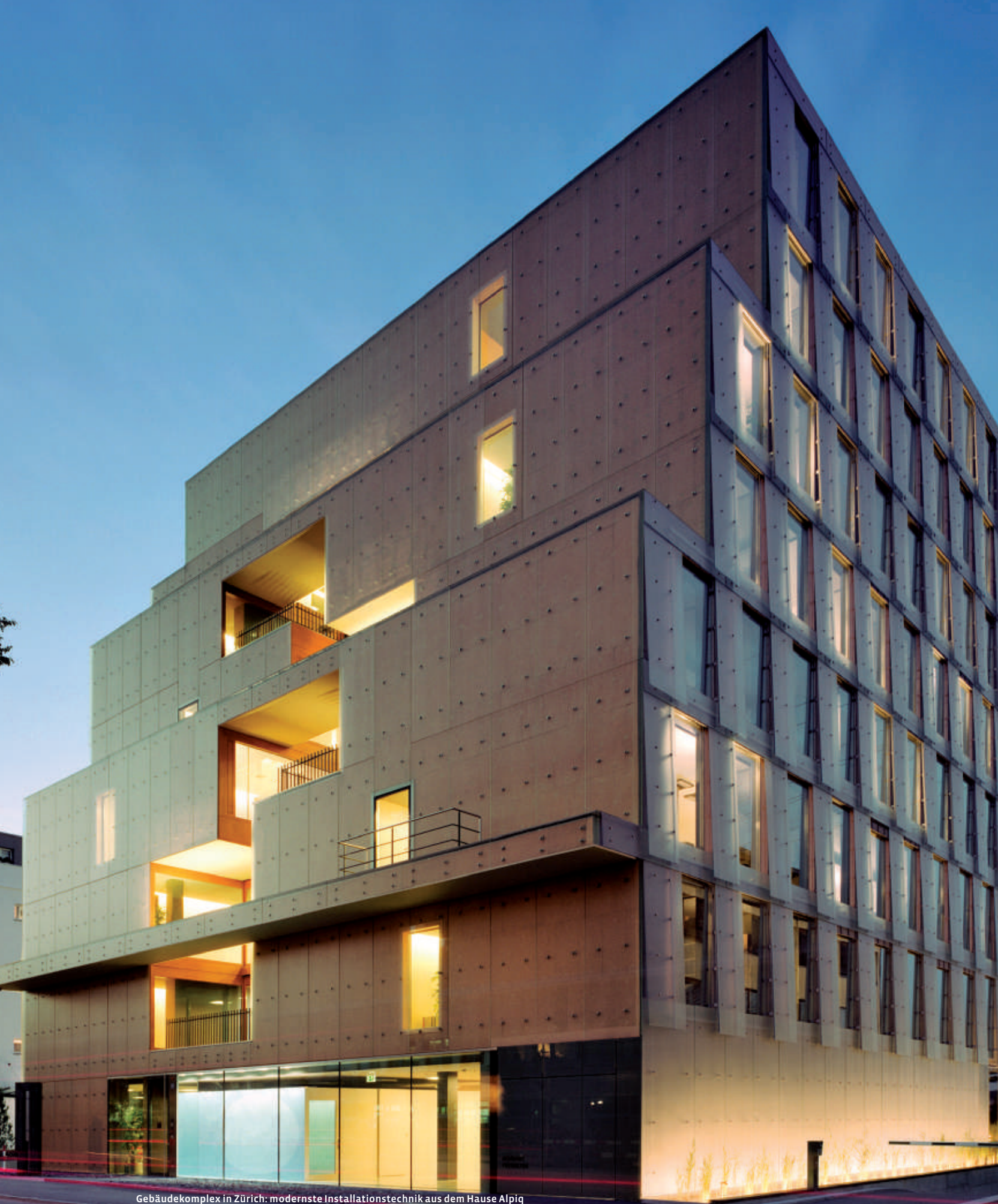
Gebäudekomplex in Zürich: modernste Installationstechnik aus dem Hause Alpiq
